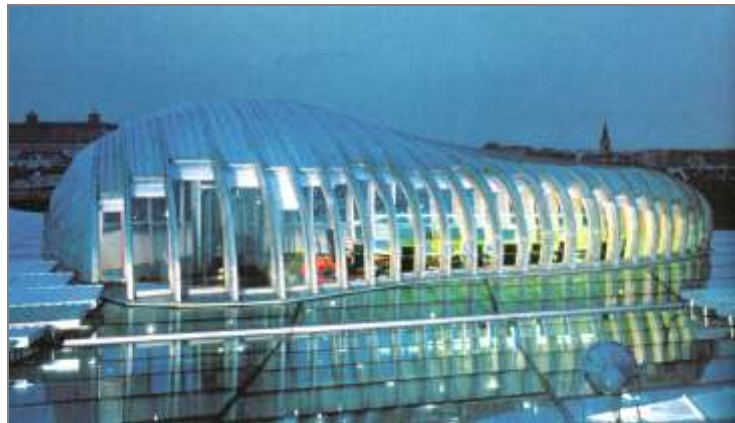
Abb. 32: ING Bank - Dachaufstockung
